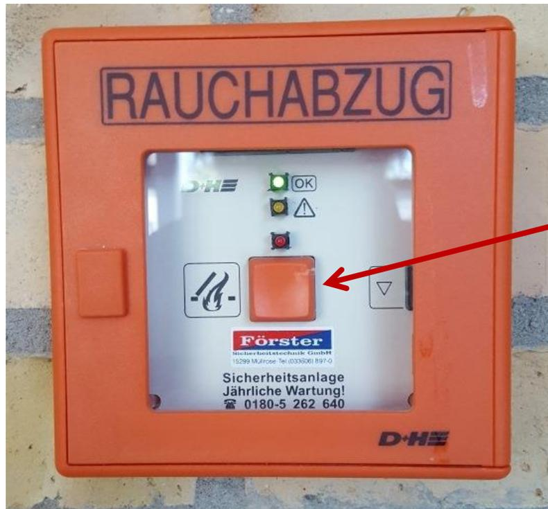
Plastikscheibe einschlagen und Druckknopf betätigen, anschließend öffnen sich alle angesteuerten Fenster / RWA-Fenster und sorgen für die Entrauchung der Fluchtwege. Hier am Bsp. Institut für Biochemie
